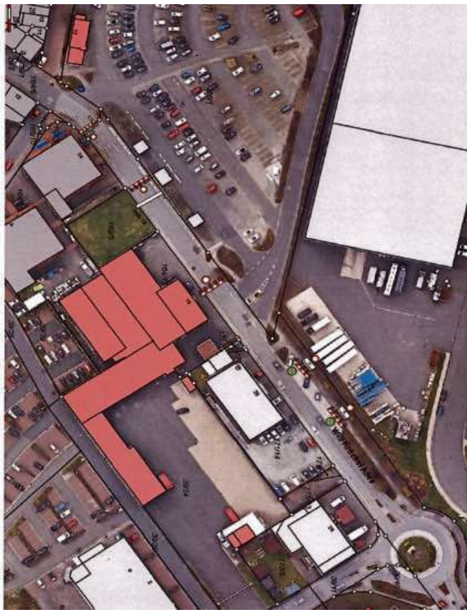
Baustelle in der Kreuzgasse
