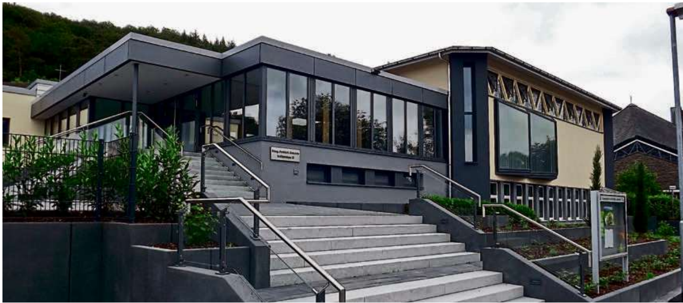
Die Evangelisch Freikirchliche Gemeinde Haiger (Schillerstraße).
