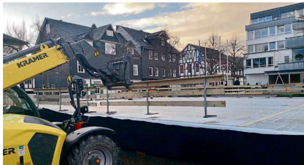
Anfang dieser Woche haben die Abbauarbeiten am Marktplatz begonnen. Die Kollegen des Haigerer Bauhofes hatten alle Hände voll zu tun. Foto: Ralf Triesch/Stadt Haiger
