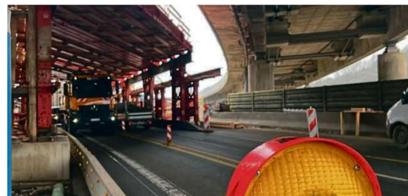
Das Traggerüst schränkt die Durchfahrtshöhe unter der Brücke ein (unteres Bild). Um Schäden am Gerüst zu verhindern, gibt es eine Höhenbeschränkung. Fotos: Autobahn Westfalen
