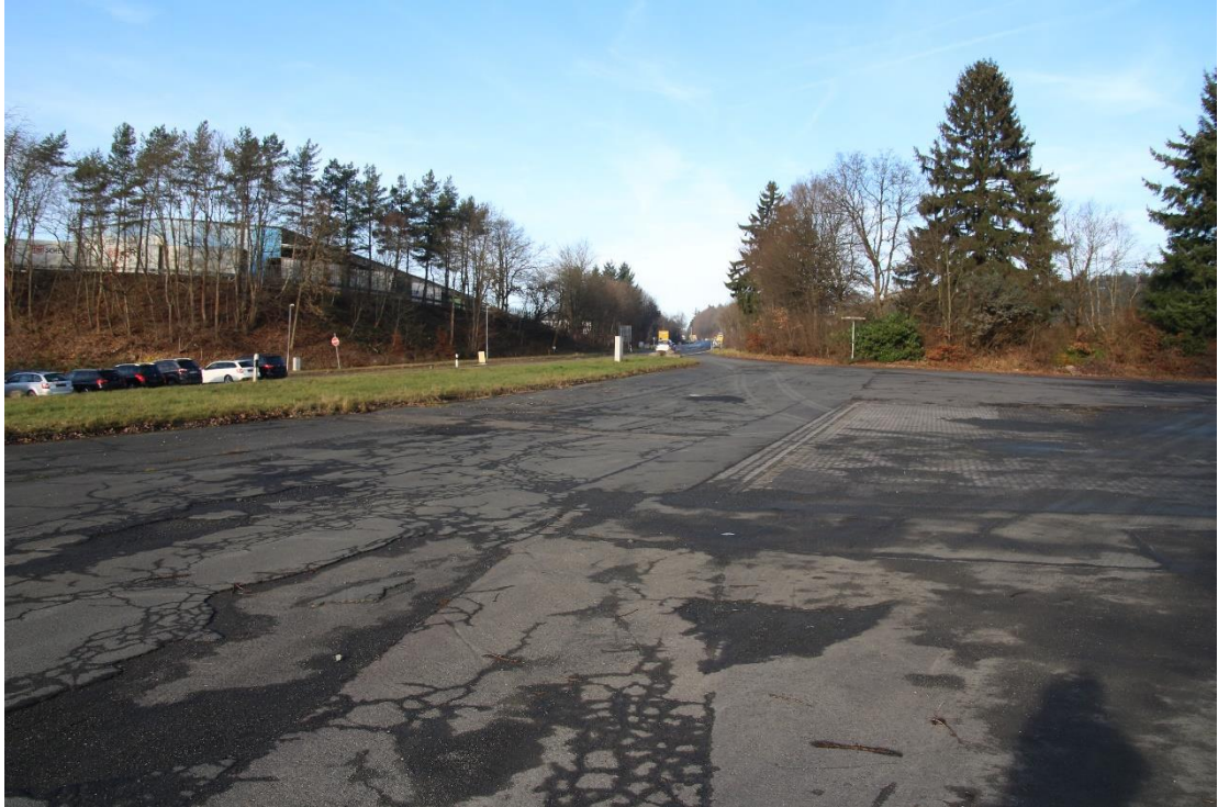
Foto 3: Blick auf die asphaltierte Fläche, in der Bauverbotszone gelegen (Quelle Büro Zillinger, 2016)
