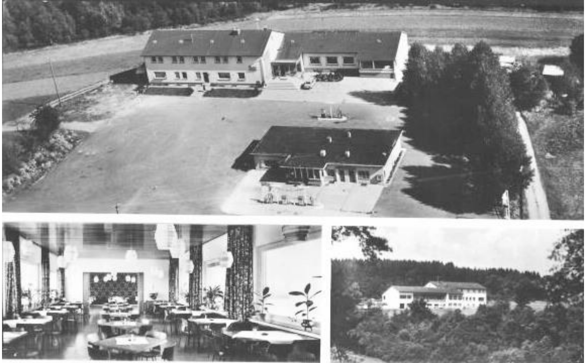
Foto 1: Ehemaliger Rasthof Kalteiche mit Tankstelle
