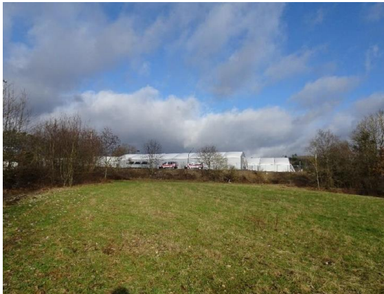
Blick von Süden auf die Schotterauffüllung mit dem Containerdorf.
