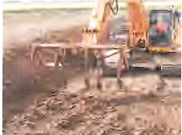
*Lockerung des Planums vor Bodenauftrag mit Tiefengrubber. Ein Wechsel zwischen Baggerlöffel und Tiefengrubber ist mittels Schnellkupplung leicht möglich. © Gerhard Dumbek*
