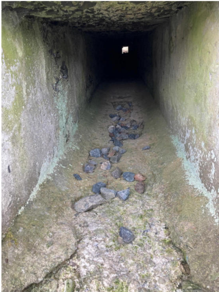
Bild Nr. 1: Alter Bahndurchlass von Unterwasser aufgenommen
