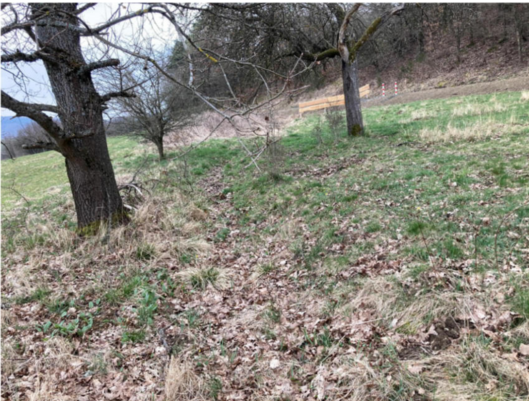
Bild Nr. 4: vorh. Mulde muss leicht nachprofiliert werden
