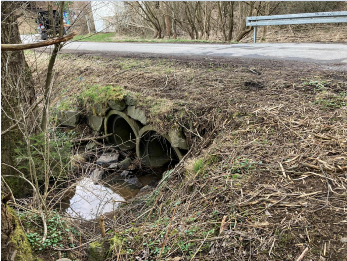
Bild Nr. 6: Einlaufbauwerk Petersbach
