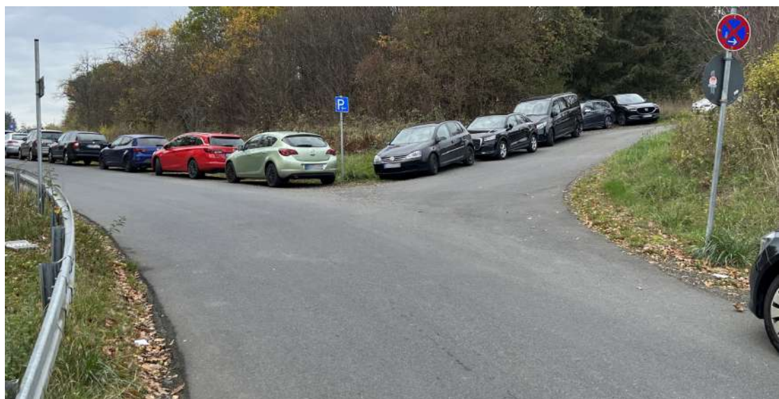
Abb. 35: Einmündung des Panoramaweges (rechts) in die Sportplatzstraße
