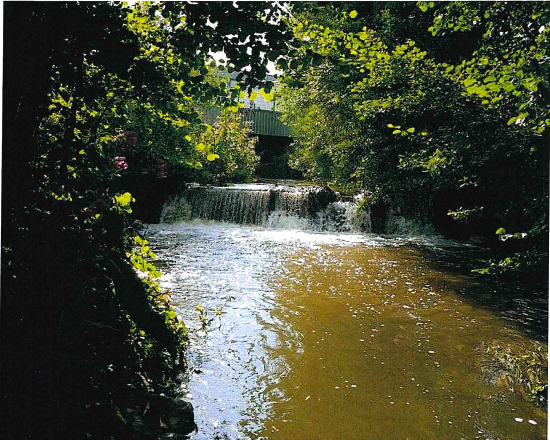
Abb. 16: Blick auf das Wehr von Osten auf den Übergang zwischen den Betriebsteilen
