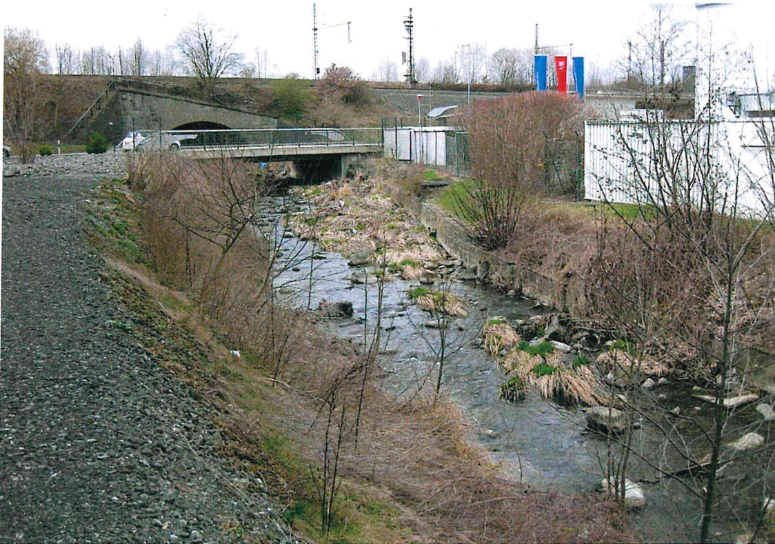
Abb. 23: Böschung mit Stützmauer und geschotterte Feuerwehrumfahrung
