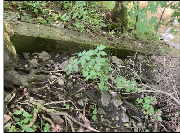
Abb. 11. Mit Pflaster verbaute Ufer zur Sicherung der Brückenfundamente.
