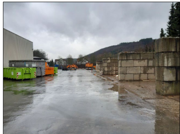
Abb. 3: Blick nach Osten über das Betriebsgelände.
